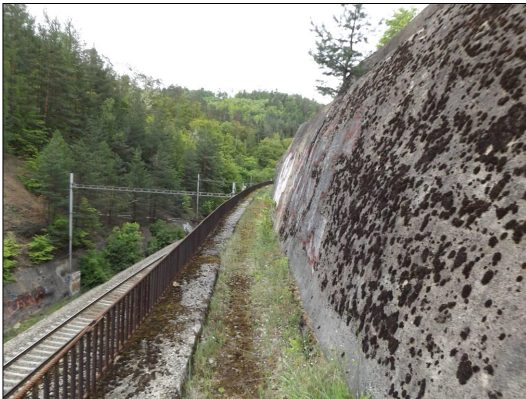
Obr. č. 9 – pohled na korunu zdi a skalní výchoz krytý stříkaným betonem
