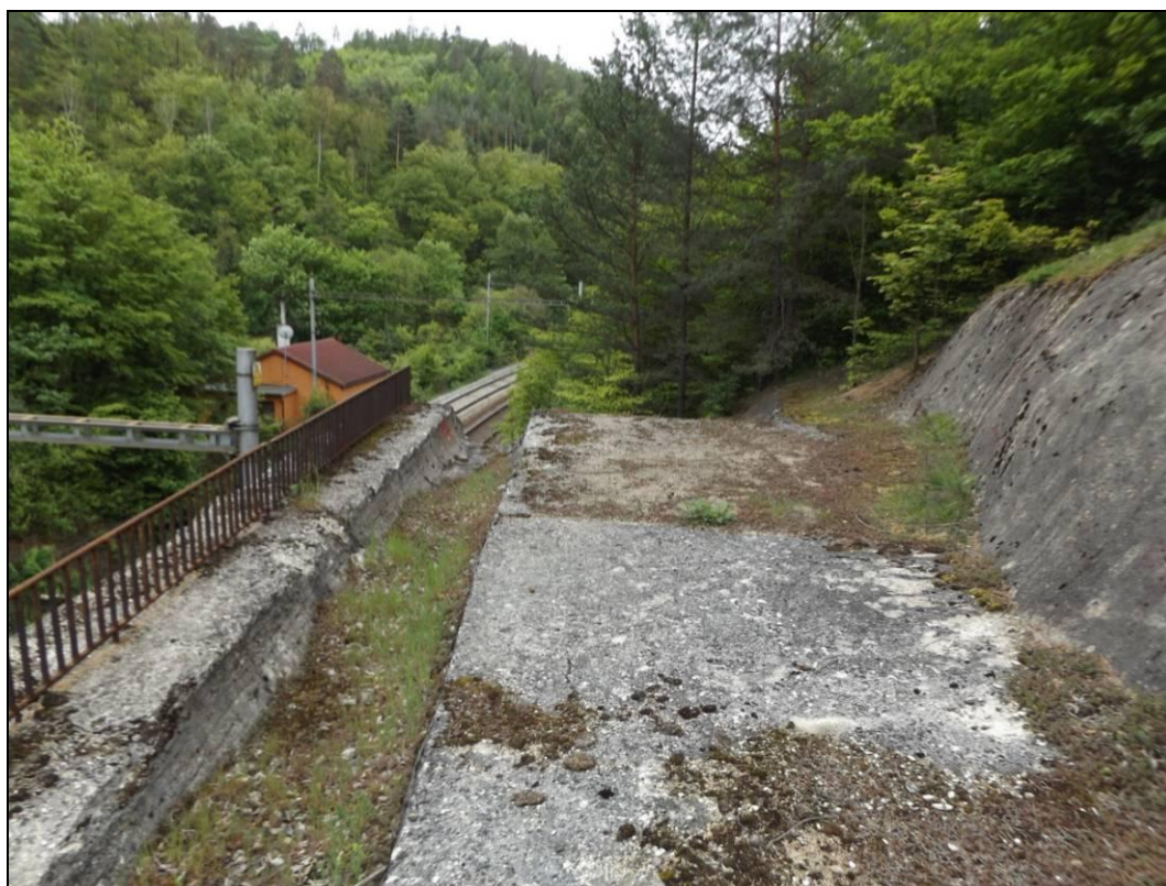
Obr. č. 10 – pohled na korunu zdi a skalní výchoz krytý stříkaným betonem
