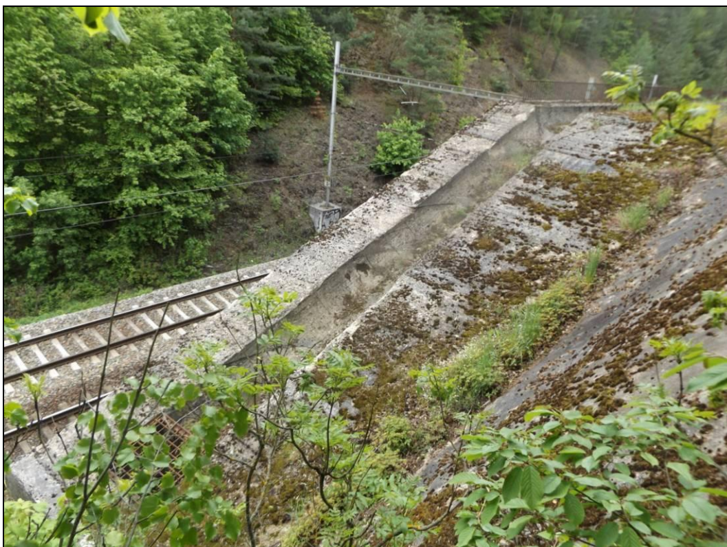
Obr. č. 8 – pohled shora na půlkruhový odvodňovací žlab v koruně zdi
