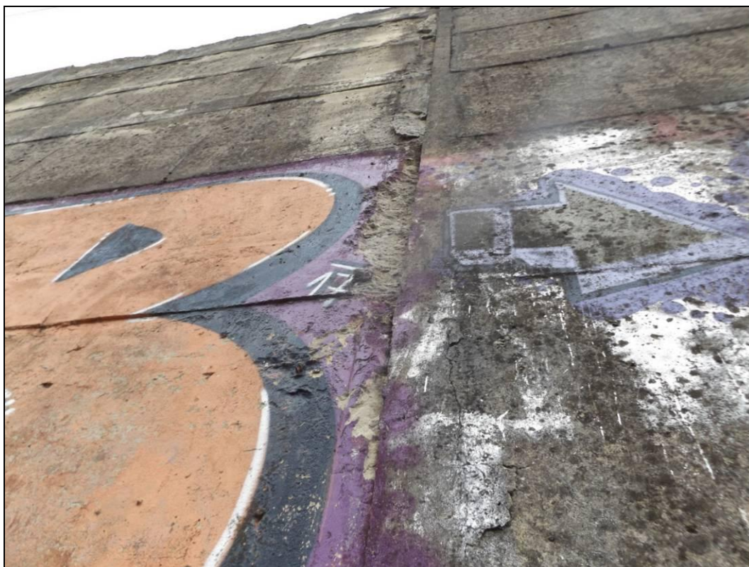
Obr. č. 7 – pohled na dřík zárubní zdi a dilatační spáry postižené vyšším stupněm degradace než okolní beton
